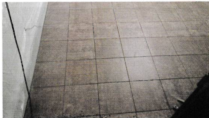
Nová podlaha kuchyně KD.
