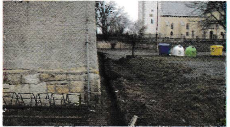
Došlo k odvedení vody ze svodů budovy KD Kunčina.
