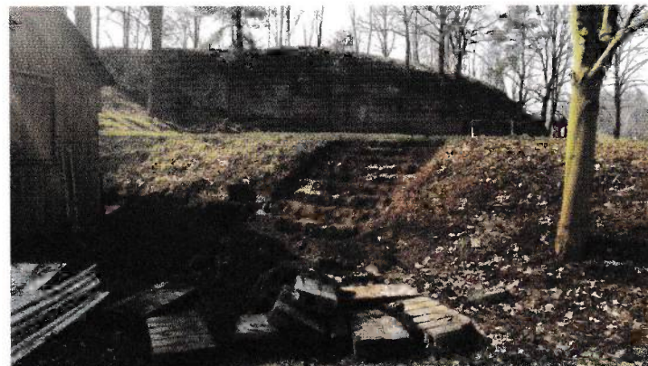
Staré úzké betonové schody byly vykopány.
