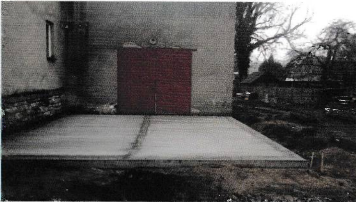
Základní deska přístavby.
