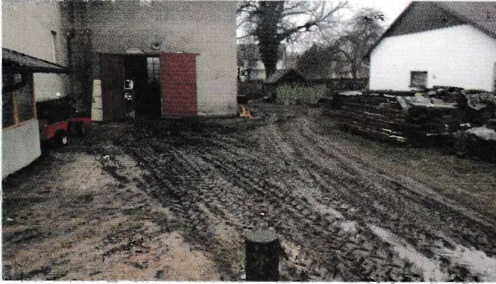
Sklad bude přístavěn ke stávající garáži, bude opravena i stávající nebezpečná cesta.
