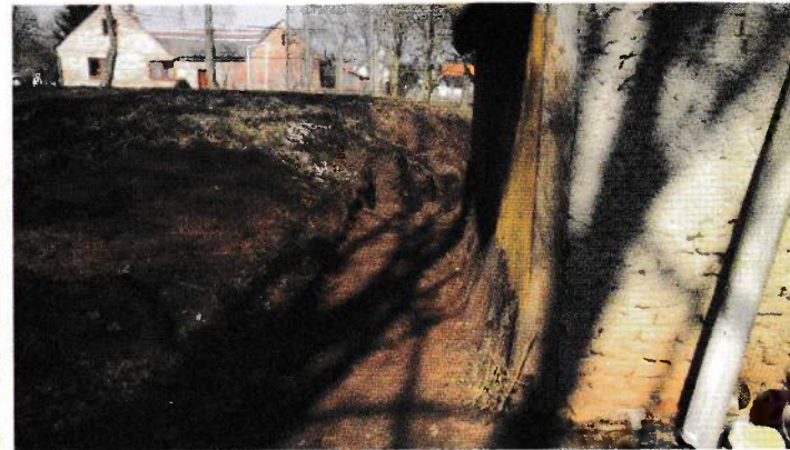
Prostor za chatkou byl odvodněn, byla provedena příprava pro pěšinku.
