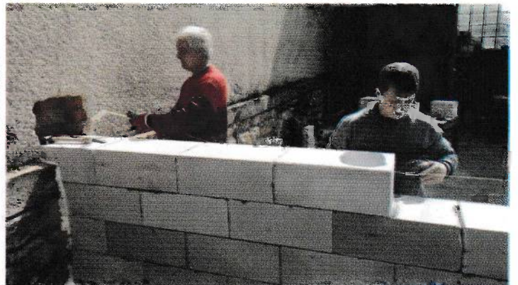
Vyzdívání obvodových zdí.
