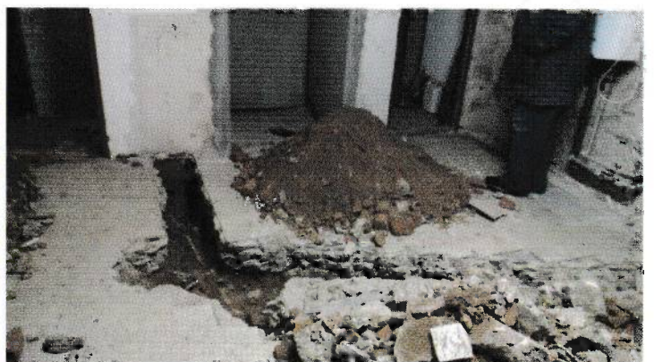
Byly zhotoveny nové odpady, rozvody elektřiny a vody.
