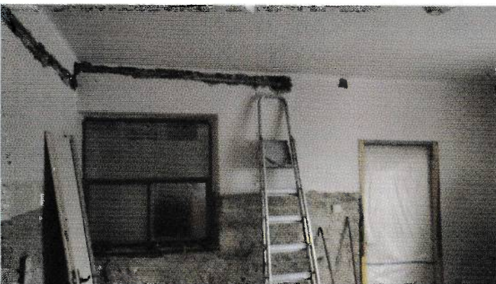
Kuchyně v první den oprav, byla vyklizena, původní nevyhovující vybavení odstraněno.
