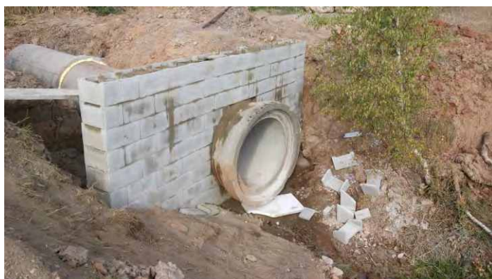
Most byl téměř kompletně vybudován pracovníky obce, pouze zemní práce a uložení skruží byly realizovány dodavatelsky
