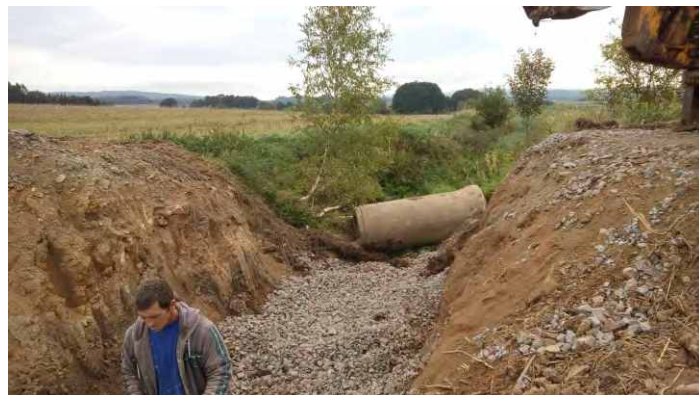
Obnova propustku na cestě k Mladějovu, původní most byl zcela demolován
