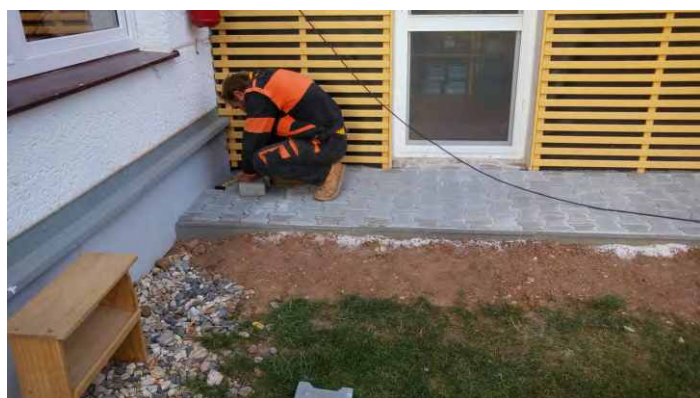
Dokončovací práce na novém chodníku
