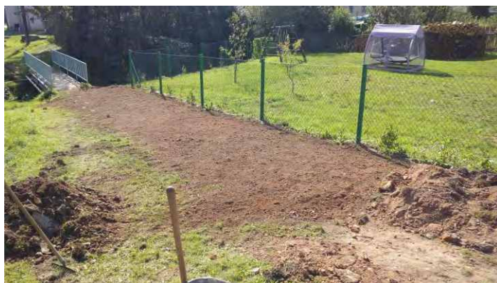
Oprava VO s sebou přinesla složité zemní práce z důvodů uložení nového kabelového vedení.
