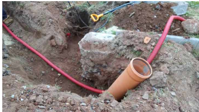
Opravy rozsáhlé poruchy veřejného osvětlení v lokalitě u okálů v Kunčíně s posunutím sloupu VO
