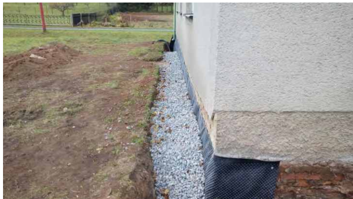
Výkop byl opatřen drenážní trubkou, zasypán šterkem a stěny budovy izolovány
