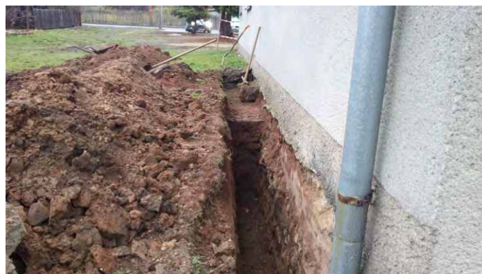
Obkopání budovy Klub důchodců v Kunčíně z důvodu velké vlhkosti budovy, výkopové práce byly provedeny ručně, aby nebyla budova poškozena
