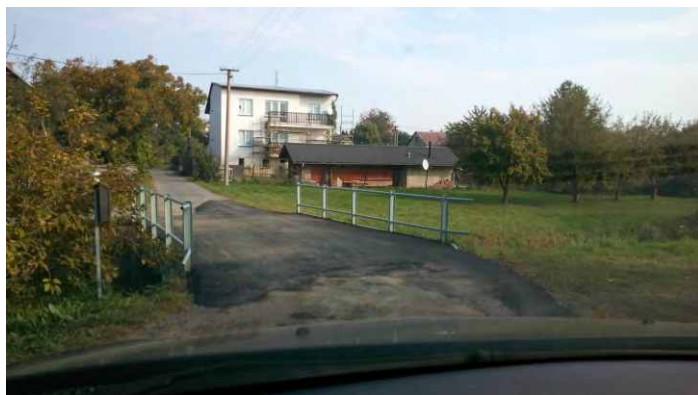
Most po rekonstrukci
