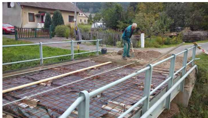
Most byl opatřen novými vrstvami krom konstrukčních, následně byl vybetonován, izolován vůči vodě a připraven pro asfaltování
